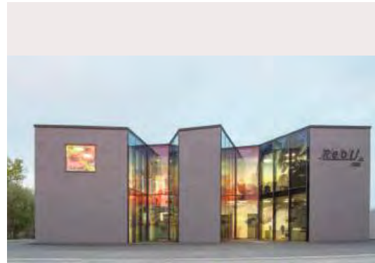
neubau bürogebäude fa. rebl
