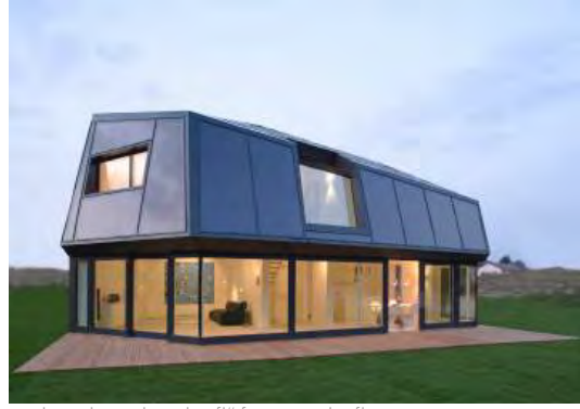
neubau „haus der zukunft“ fa. sonnenkraft
