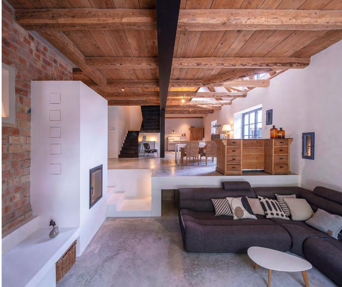
UM DEN HISTORISCHEN CHARAKTER des Hauses zu erhalten, wurde die statische Tragstruktur der Decke im Erdgeschoss mit sichtbaren Stahlprofilen ergänzt, die durch ihre schwarze Lackierung markante Akzente setzen.
