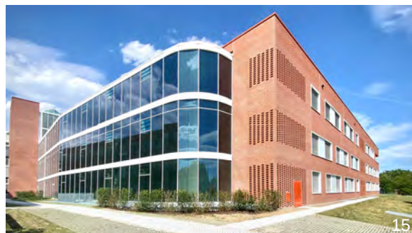
Kreuger Wilkins Architekten | TPK Freie Architekten Staatliches Bauamt Regensburg, Hochschulbau Universitätsklinikum, Neubau Entlastungsgebäude B5 Franz-Josef-Strauß-Allee 11
