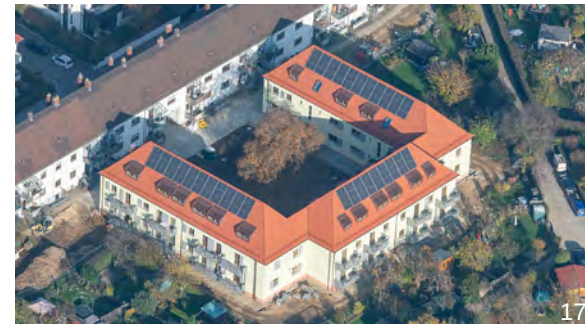
Luxgreen Climadesign GmbH Baugenossenschaft Margaretenau eG MAGGIE – Energetische Sanierung Lindenstraße 7,9,11,11a,13,15
