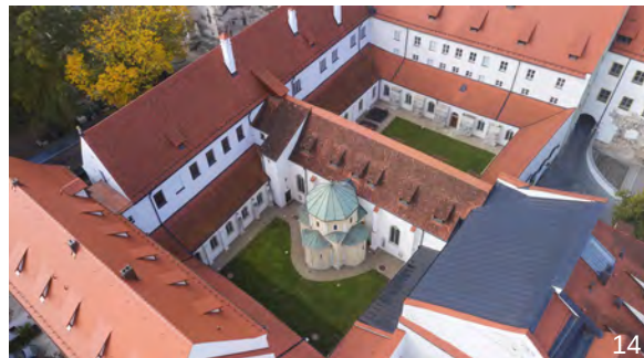
Ingenieurbüro Dipl. Ing. Hans Siegmüller Staatliches Bauamt Regensburg, Bereich Hochbau Sanierung Domkreuzgang und Domkapitelhaus Domgarten 1
