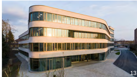
Gewers Pudewill REWAG Regensburg Unternehmenszentrale der REWAG Grefflingerstraße 26
