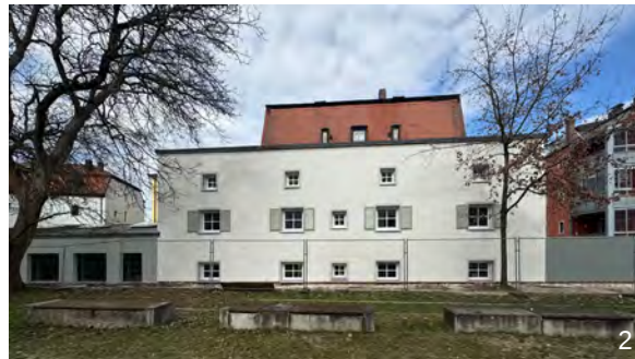
Basqué Et Partner, Ulla Basqué Lost Place – Sanierung und Umnutzung zum Wohn- gebäude
