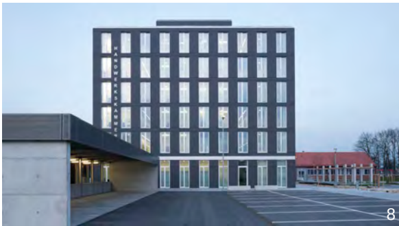
Hauptverwaltung der Handwerkskammer Niederbayern-Oberpfalz | Ditthornstraße 10 Schwinde Architekten Partnerschaftsgesellschaft mbB Handwerkskammer Niederbayern-Oberpfalz
