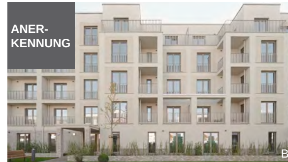
Karolinenhof Regensburg O&O Baukunst Hubert Haupt Immobilien Holding
