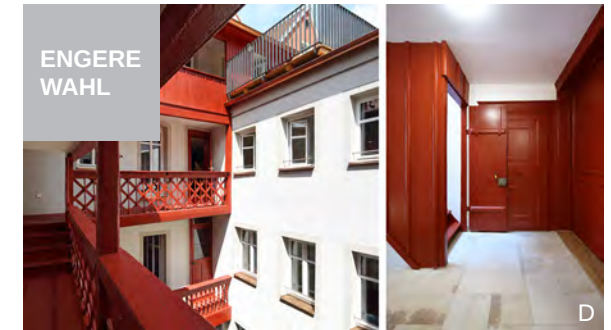
Sanierung Einzeldenkmal Am Ölberg 9 Architekturbüro Ferdinand Weber Philipp Bittner
