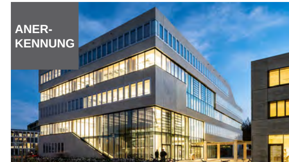
OTH Regensburg Neubau Architektur Henning Larsen Architects Staatliches Bauamt, Bereich Hochschulbau
