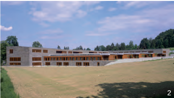
Blindeninstitutsstiftung | An der Brunnstube Georg • Scheel • Wetzel Architekten GmbH Blindeninstitutsstiftung Würzburg
