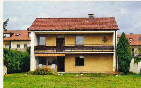
Wärmebrücken waren in den 60er-Jahren ein Fremdwort. Über den Balkon und die seitlichen Wände ging viel Energie verloren. Die Bausubstanz war so gut, dass sich eine Sanierung lohnte.
