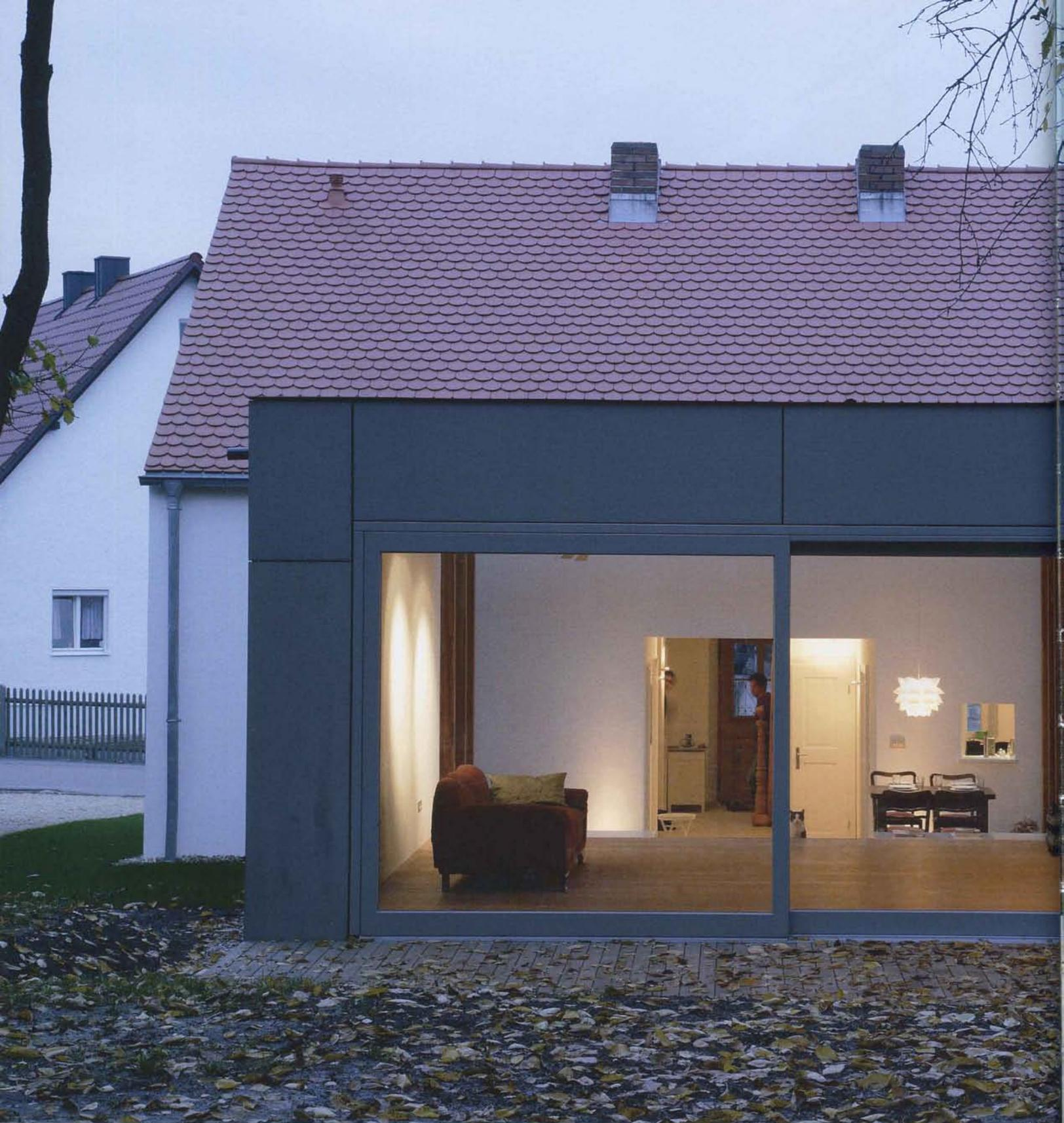
Der Neubau, ein Kubus in moderner Holzrahmenkonstruktion mit begrüntem Flachdach, Fassadenbekleidung aus geklebten zementgebundenen Faserplatten und Ganzglasfenster, ist in der Farbgebung dem Bestand angepasst. Er öffnet sich zu dem alt eingewachsenen Obstgarten – hier entstand der neue Wohnraum.
