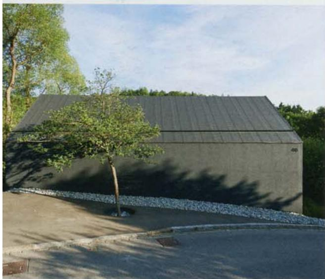
ten tauschten sich später aus – und wir haben uns tatsächlich ein paar Tricks bei der Dachkonstruktion anschauen können. Etwa wie man die Bitumenbahnen am besten verklebt oder das Regenwasser nach unten ableitet. Es sollte nämlich nichts die Geschlossenheit der Fassade stören, auch keine Regenrinnen oder Temperaturfühler. Hätte man eine Röntgenbrille auf, würde man sehen, was für ein Drainagenwunderwerk sich unter der Außenhülle verbirgt.
