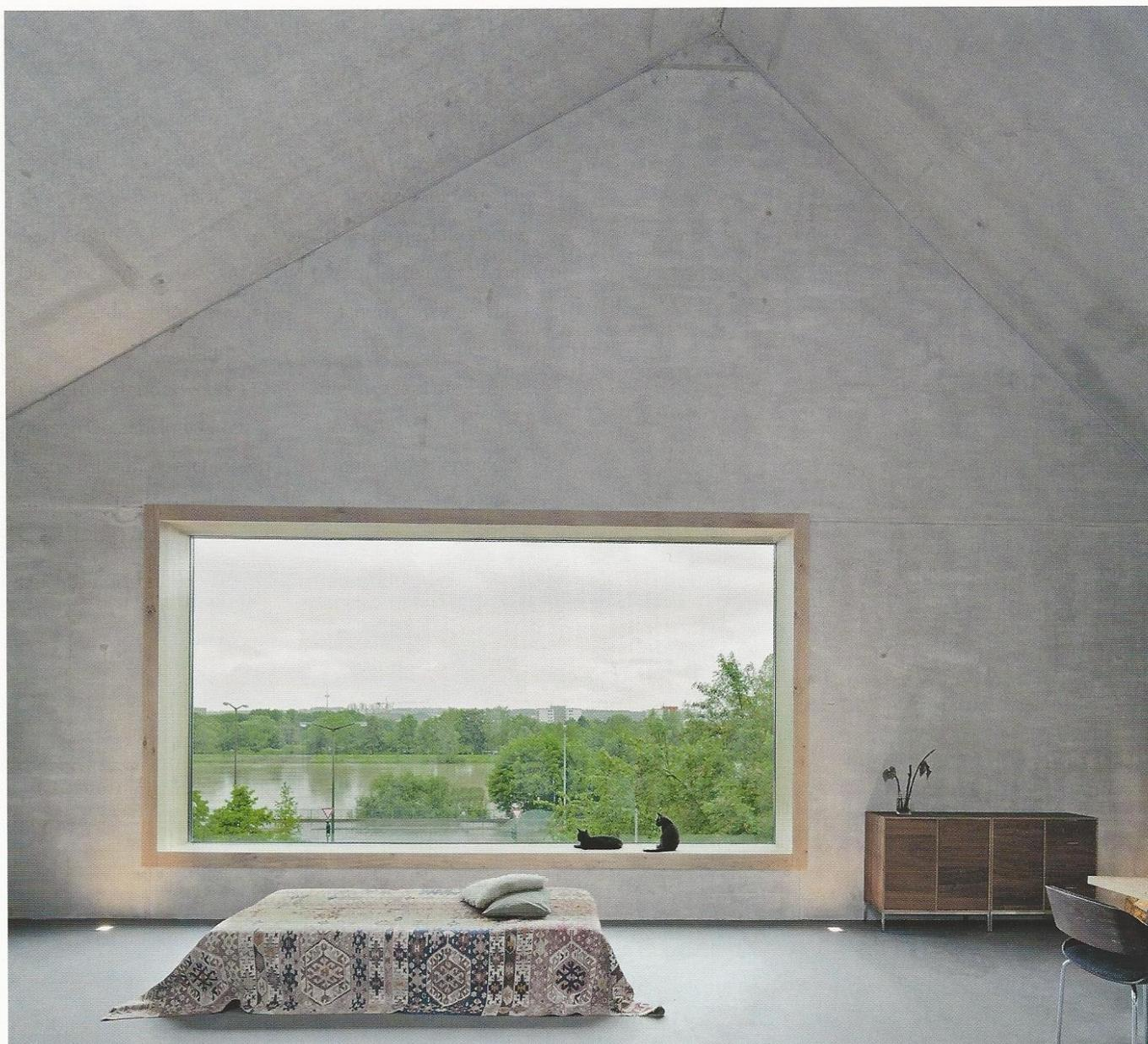
Abb. 1.50: Wohnhaus in Regensburg mit Betondach. Die Bauweise mit Betonfertigteilen ist im Innenraum des Hauses sichtbar und spürbar. Die Stahlbeton-Fertigteile des Daches haben einen Querschnitt von 220 mm.
