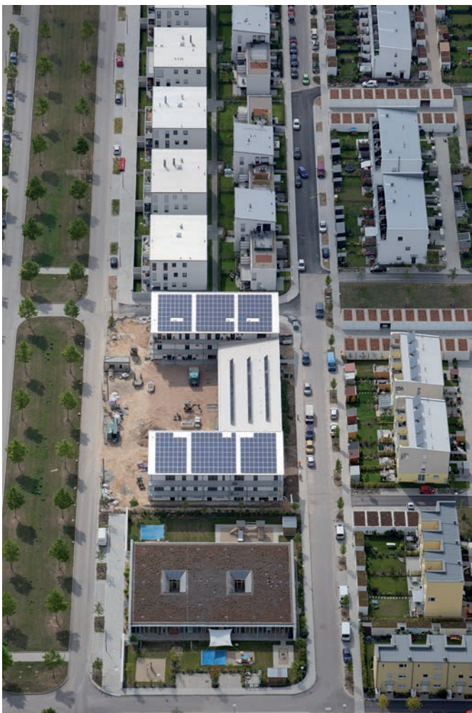
Bild 6. Eine großflächige PV-Anlage zur Stromerzeugung wurde auf den Dächern des Ost- und Westflügels installiert
