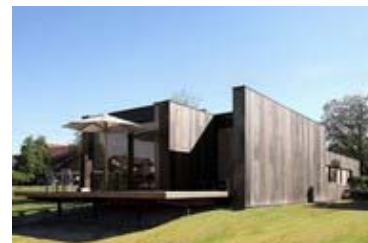
Foto: Koeberl Doeringer Architekten
