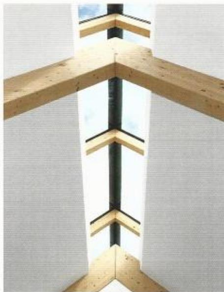
93.1: Vier freitragende Brettschichtholz-Rahmenbinder bilden einen stützenfreien Dachraum. Der verglaste First lässt in den Himmel blicken. (Arch.: Fabi)
