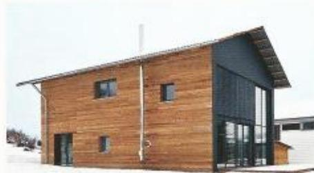
95.3: Unbehandelte sägeraue horizontale Brettschichtung an den Trauffassaden stehen in Kontrast zu den dunklen Giebelflächen.
