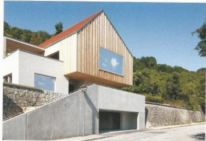
84.4: Das Hanggeschoss in Betongrau ist klar vom eigentlichen Wohnhaus abgesetzt. Der im Hang liegende Schlafraum und das Bad werden über einen Lichtschacht mit Tageslicht versorgt. (Arch.: Fabi Architekten)
