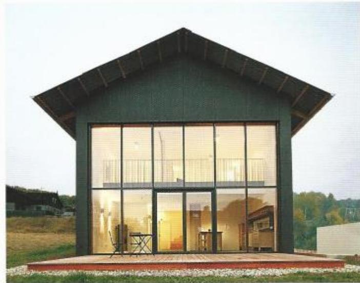
95.4: Die Einfachheit der Dachkonstruktion mit Wellplatten als Dachhaut setzt sich in den Fassaden in veredelter Ausführung fort: Schwarze glatte Faserzementtafeln und die großflächige Verglasung verleihen dem Haus Eleganz.
