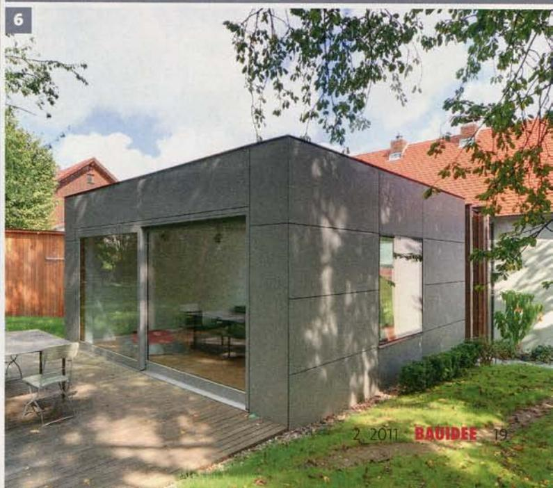
Konstruktion aus Holzrahmen in Breite und Höhe des Anbaus, deren Zwischenräume mit einer Festverglasung gefüllt wurden. Der so entstandene Raum hat den Charakter eines Wintergartens. Hier findet sich heute der Essplatz, der mit der Küche über ein zur Durchreiche umfunktionierte ehemaliges Fenster verbunden ist.
