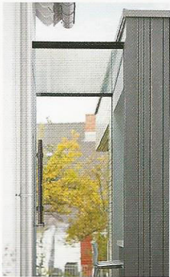
Eine mit Glas gefasste Fuge erhält die Eigenständigkeit des Bestehenden ebenso wie die des Angefügten.
