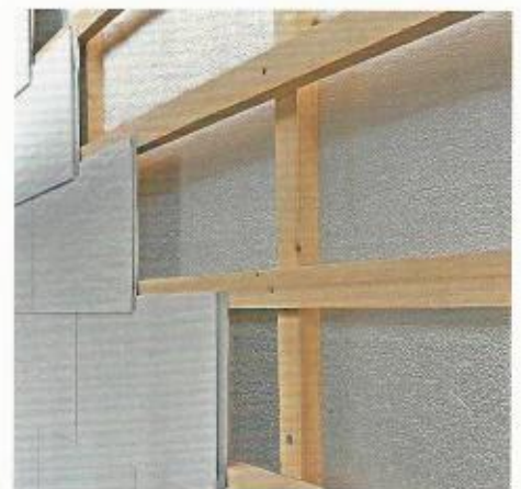
Die Fassadenplatten werden auf einer Unterkonstruktion befestigt, der Wandaufbau dahinter ist belüftet.
