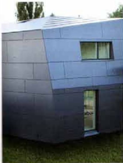
Dach und Außenwand sind mit dem gleichen anthrazitfarbenen Material belegt
