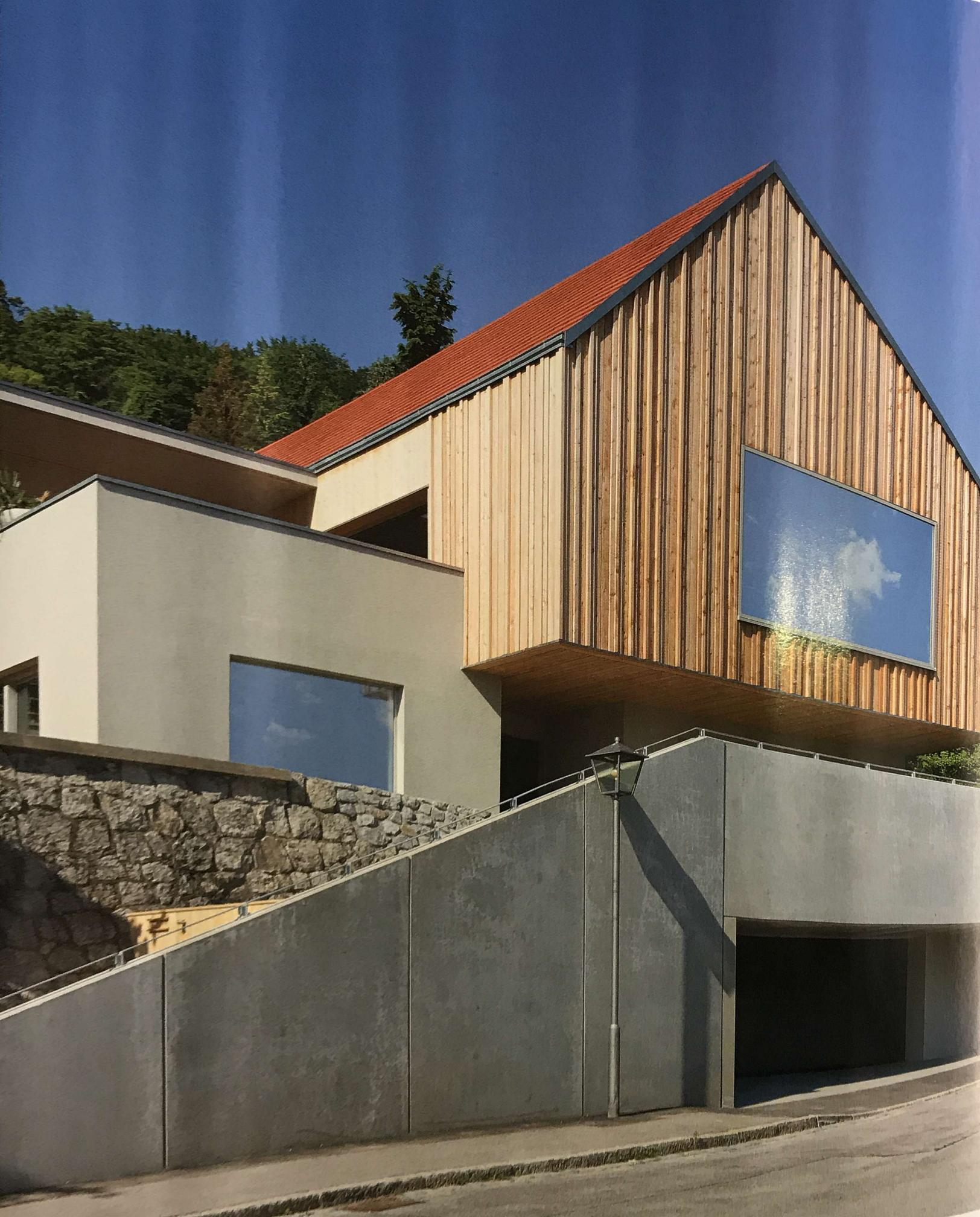
Auffallendes Charakteristikum des Hauses ist das asymmetrische Satteldach aus 24 Zentimeter dickem Beton unter einer Ziegeldecke und zurückhaltend wenige Fensteröffnungen.
