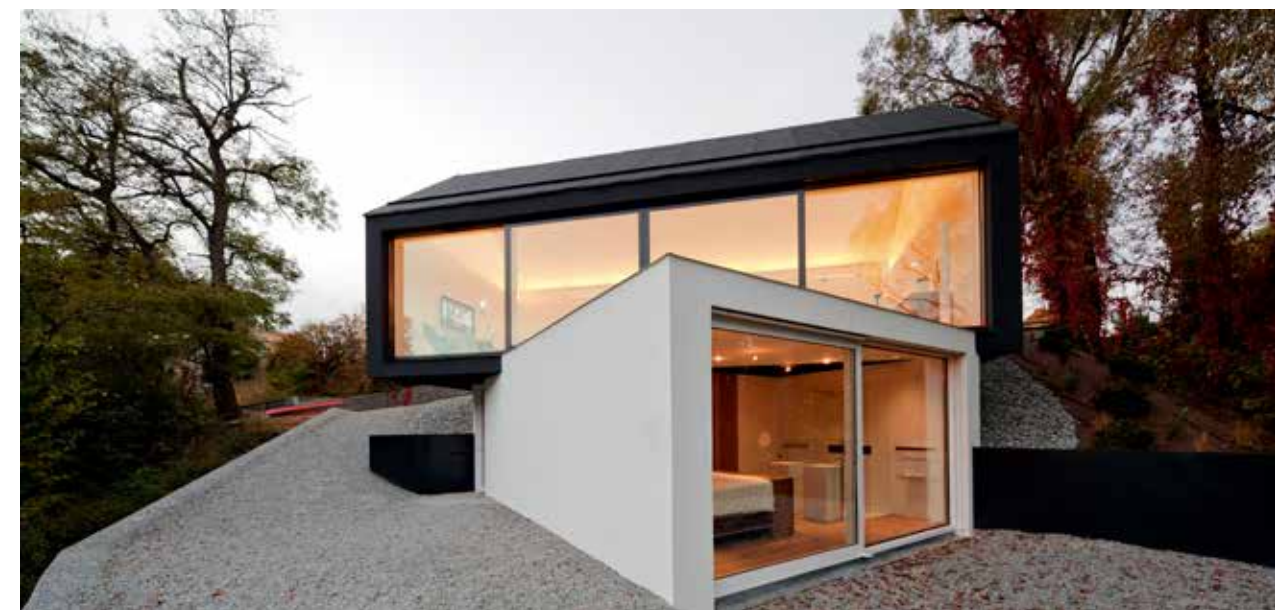
Ober- und Untergeschoss wurden gegeneinander gedreht. Dreiseitig geschlossen, öffnen sie sich jeweils zu einer Seite vollflächig.
